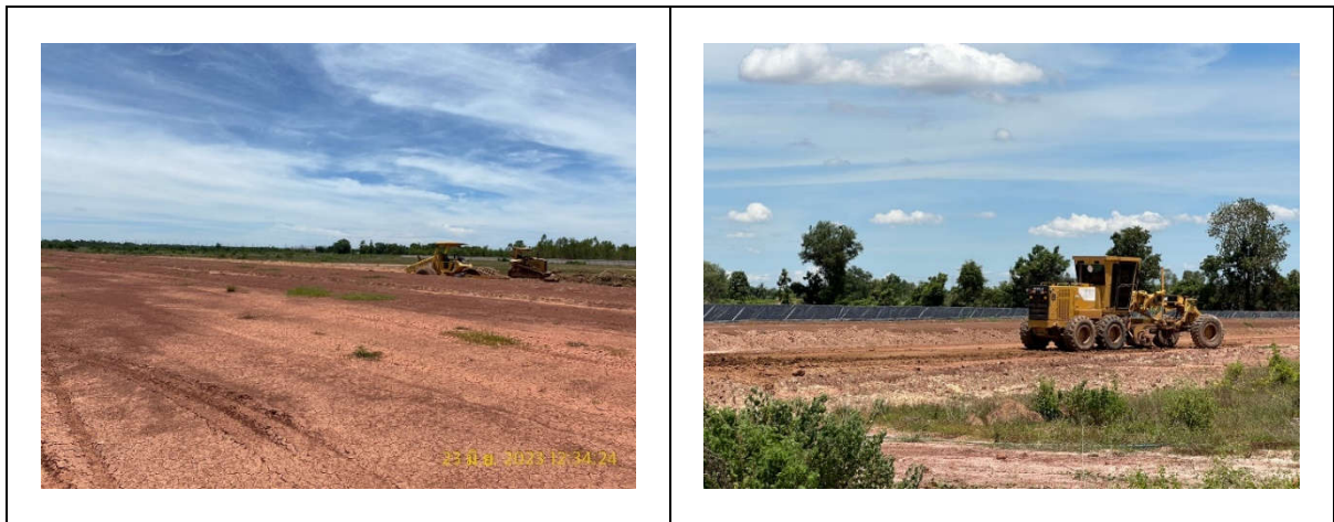
รูปถ่ายที่ 3.2-2 : การปรับถมดิน/บดอัดดินภายในพื้นที่โครงการ
