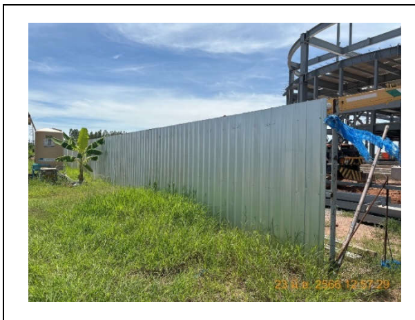
รูปถ่ายที่ 3.2-20 : กำแพงกั้นเสียงตามแนวเขตพื้นที่ก่อสร้าง
